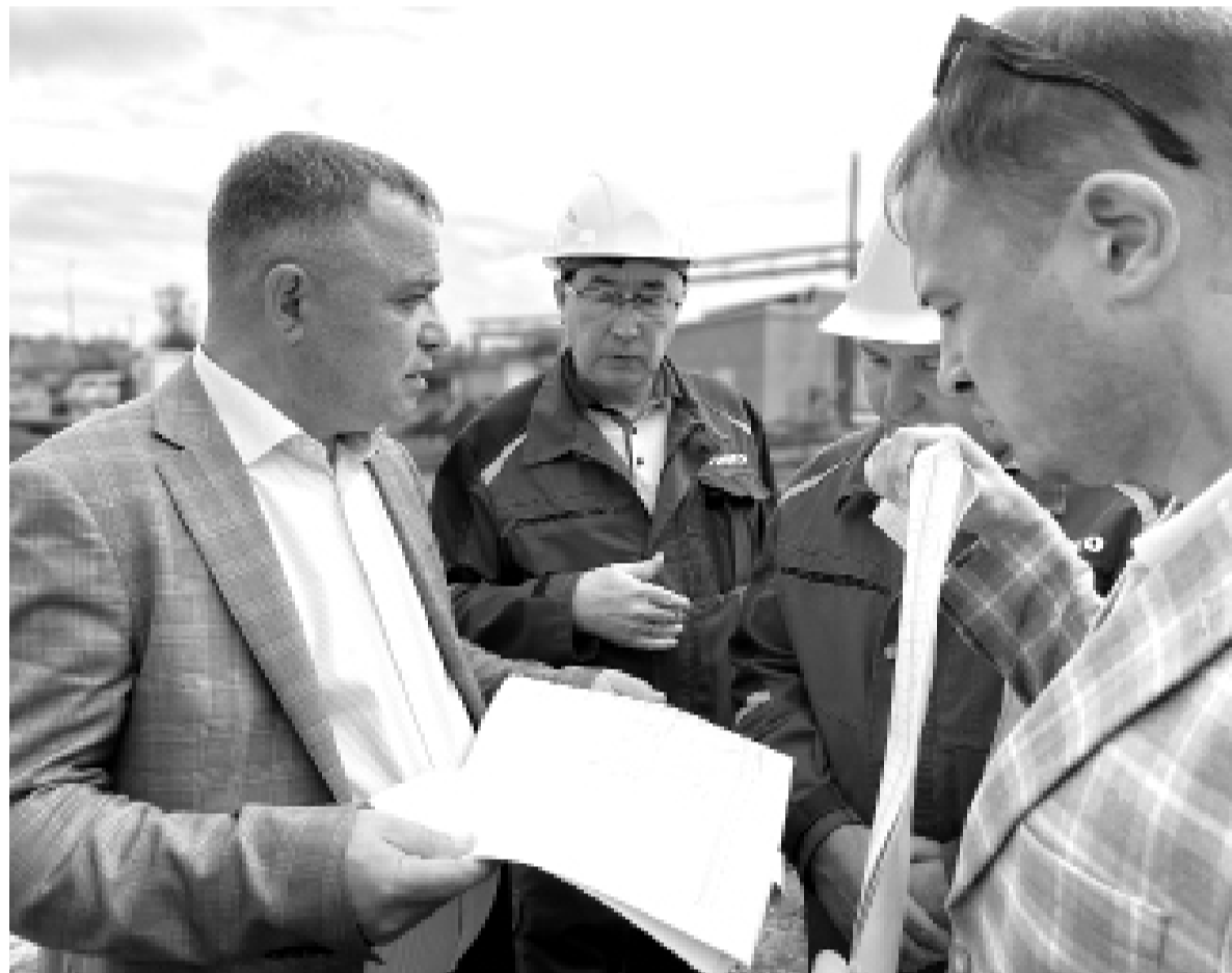
► В ходе еженедельного объезда заместитель главы города Юрий Вавакин проверил ход выполнения работ на водоочистных сооружениях
