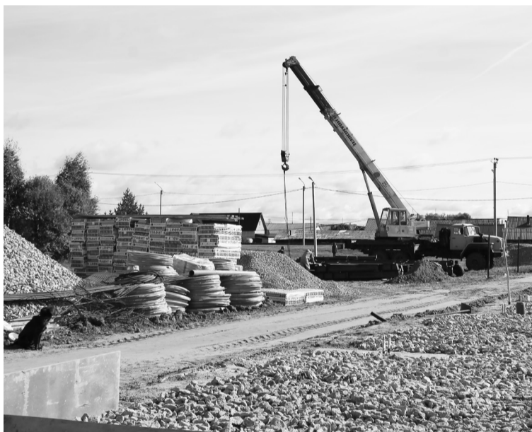
Металлоконструкции будут перевезены на подготовленную площадку и установлены там.
