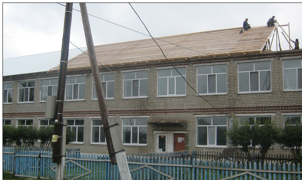
• Ведутся кровельные работы в Малиновском филиале Аромашевской средней школы.
