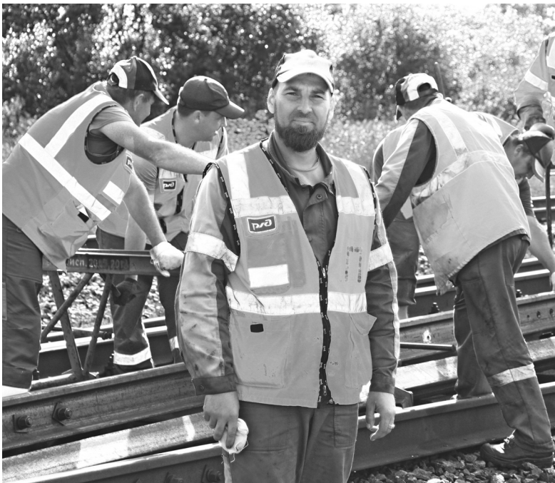
Бригада дистанции пути во главе с Артёмом Налобиным ведёт ремонт на стрелке местной станции
