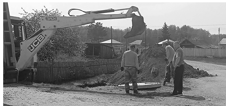
Специалисты ООО «Голышмановотеплоцентр» прокладывают водопроводные сети по улице Энгельса посёлка Ламенского
