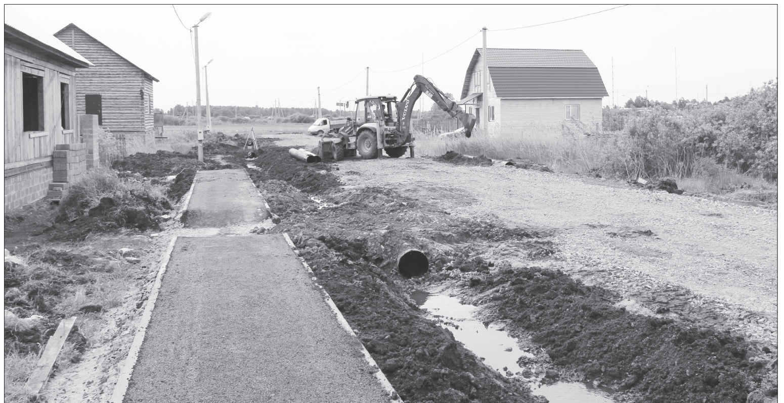
На улице Беркутской в Ялуторовске помимо новой проезжей части дорожники монтируют тротуары и съезды к домам / ФОТО АВТОРА
