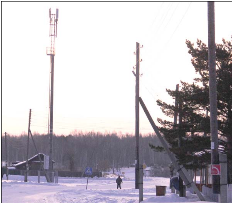
• Вышка, построенная в Ангарке, обеспечила надёжную сотовую связь.
