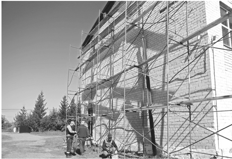
Строители «СТК Регион» отремонтировали кровлю в спортзале Гладилловской школы
