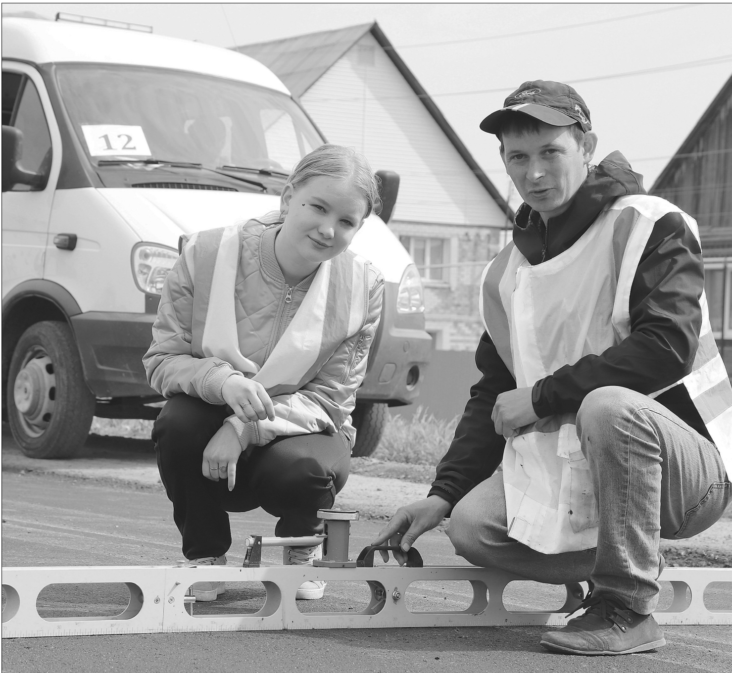
Студентка Карина Тырцова проходит практику в Голышмановском ДРСУ-4. Под руководством мастера Максима Дегтянникова измеряет уклоны рейкой Кондор, чтобы на дороге не образовывались лужи после дождя.
