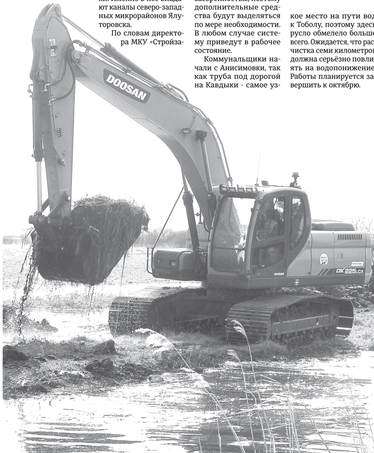
Поднятый со дна ил разравнивают по берегам канала /ФОТО АВТОРА
