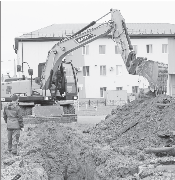
■ Подрядчики строят подводящую линию к зданию Россельхозбанка. Значит, будут с теплом. / ФОТО АВТОРА.
