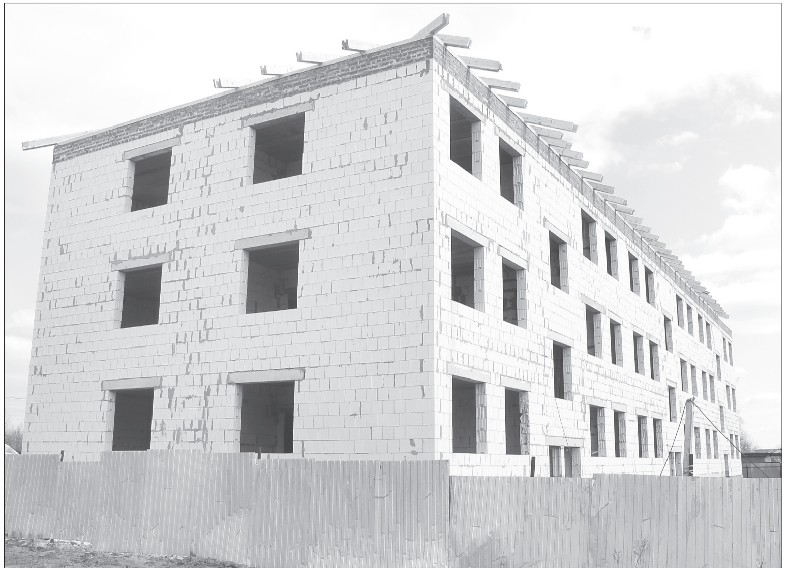
Жильцами новой трёхэтажки в переулке Шоссейном станут переселенцы из ветхого и аварийного жилья /ФОТО АВТОРА
