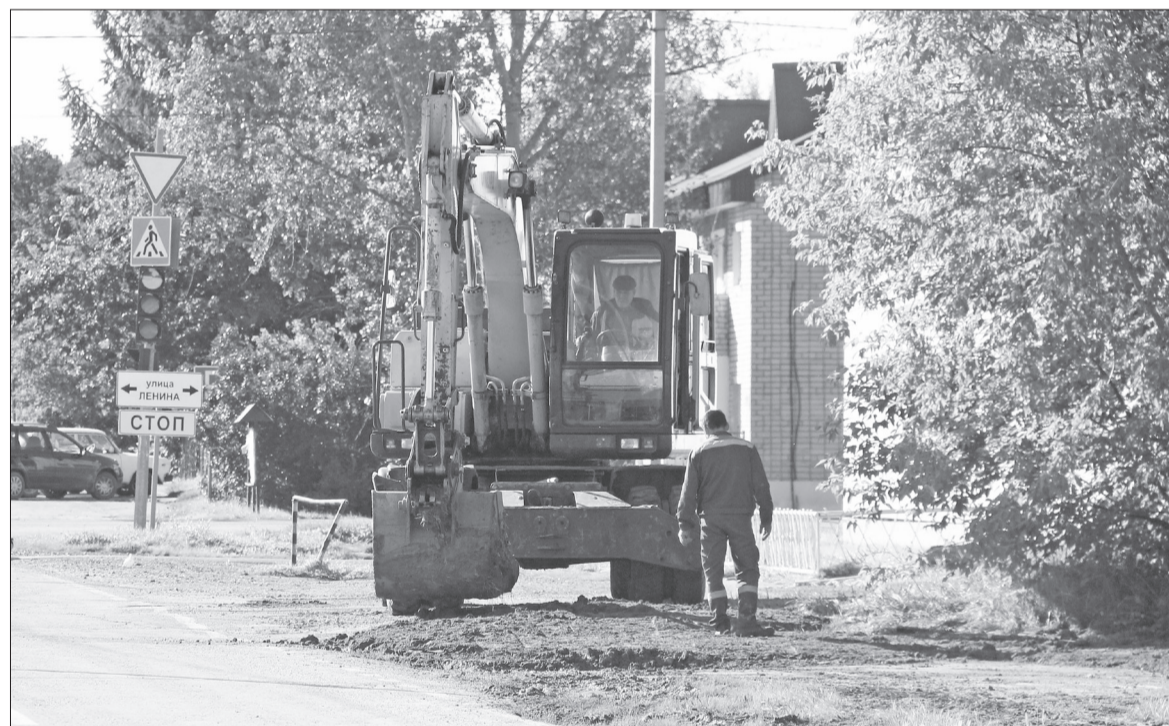
Дом на улице Мира, 1 в Нижней Тавде присоединяют к центральной канализации. / ФОТО АВТОРА.
