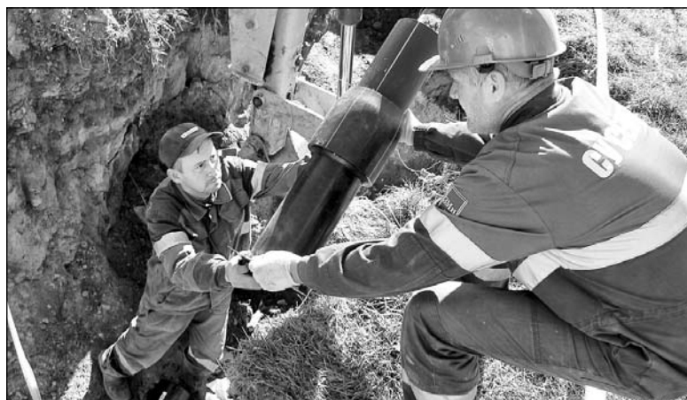
• Вопрос о газификации села Новопетрово неоднократно поднимался на сельских сходах граждан. Летом специалисты АО «СУ Север» приступили к строительству новой ветки газопровода.
