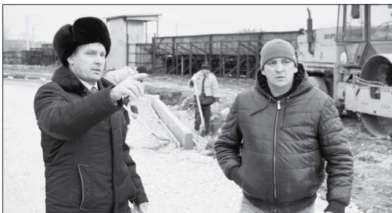
• Игорь Власов и прораб ДРСУ-4 АО «ТОДЭП» Евгений Плесовских на строительном объекте в Заречном микрорайоне. «Вопросы решаются быстрее, когда сам контролируешь ход строительства или ремонта», – отмечает руководитель муниципалитета.
