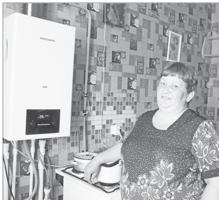
Олеся Хрулёва с улицы Строителей рассказала, как ей установили газовый котёл в рамках ремонта муниципального жилья. / ФОТО АВТОРА.
