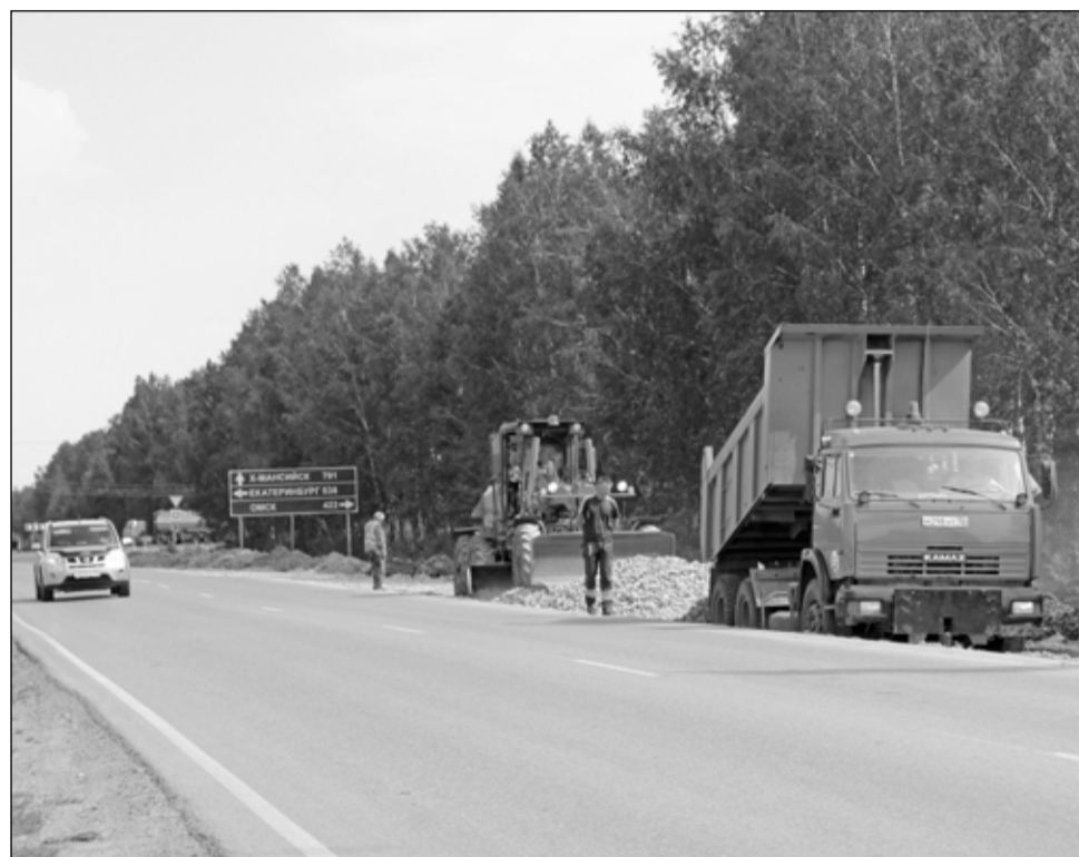
Дорожники ведут работы по обустройству обочин
