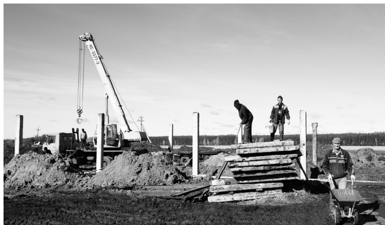
На строительстве родильного отделения
