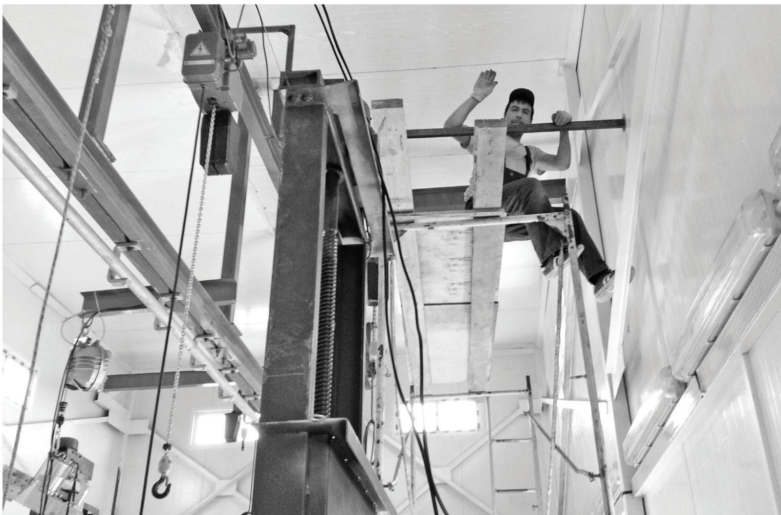
Внутри помещения заканчивается монтаж специального оборудования.
