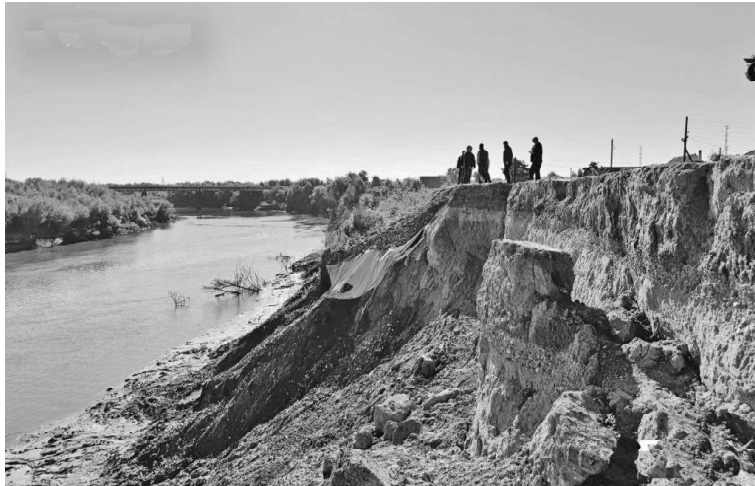
Обрушение берега р. Ишим в Викулово
