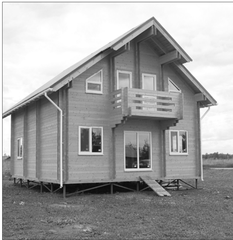
Двухэтажный деревянный дом в селе Бескозобово вырос на пустыре всего за две недели. Готова «коробка» с крышей, вставлены окна
