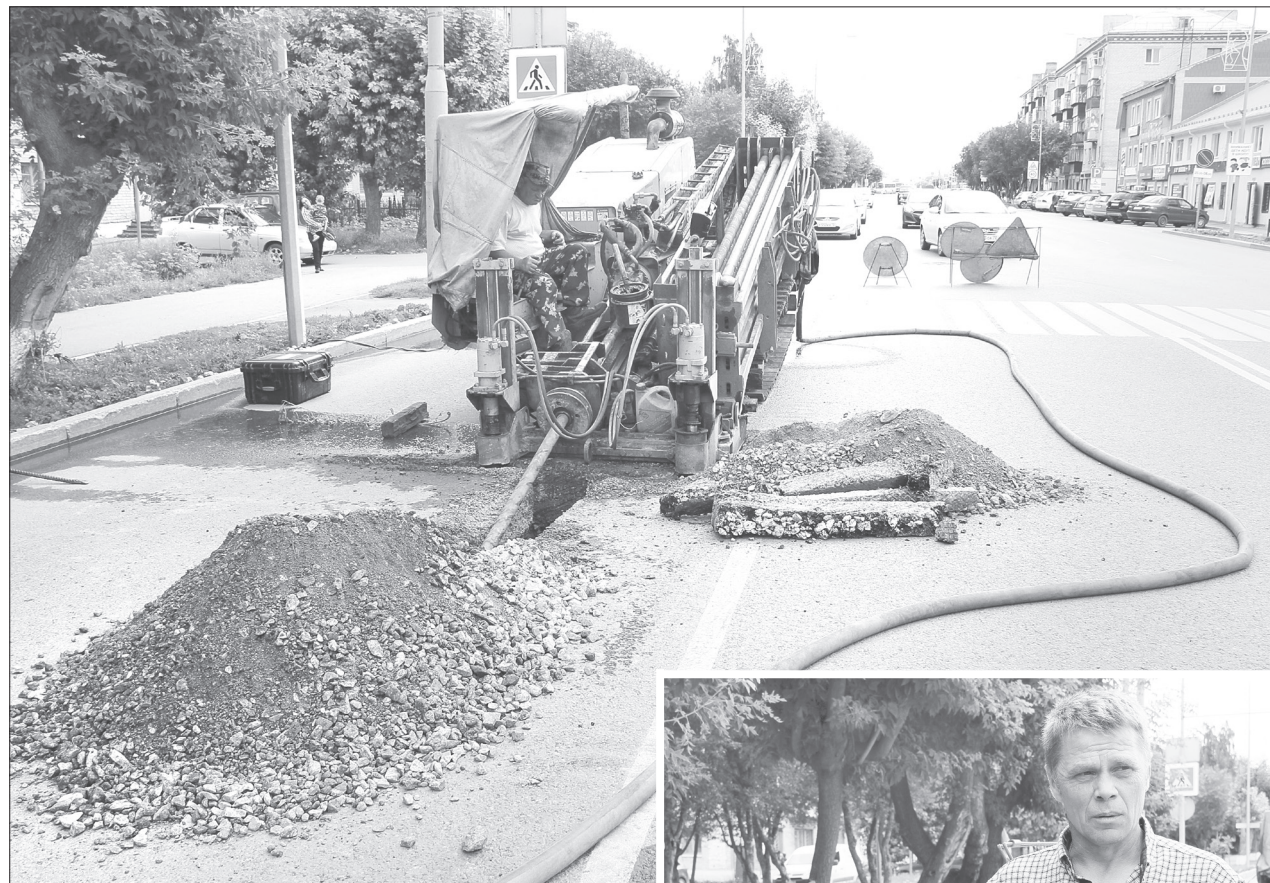
Землеройная техника соединяет колодцы трубой
