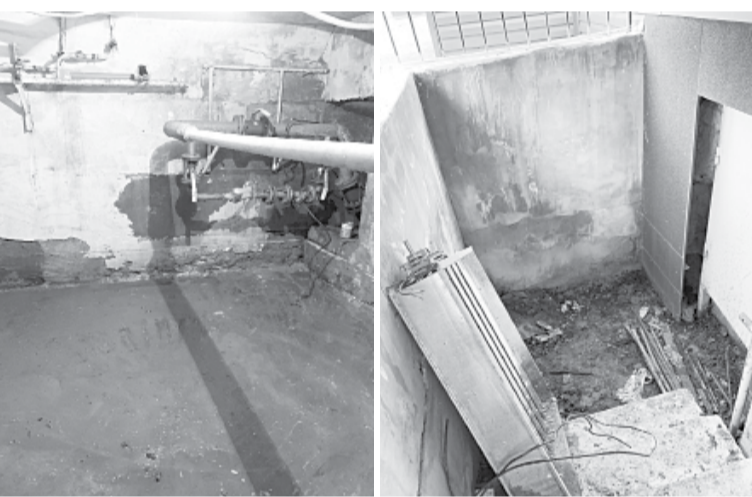
В подвале школы всё под контролем
