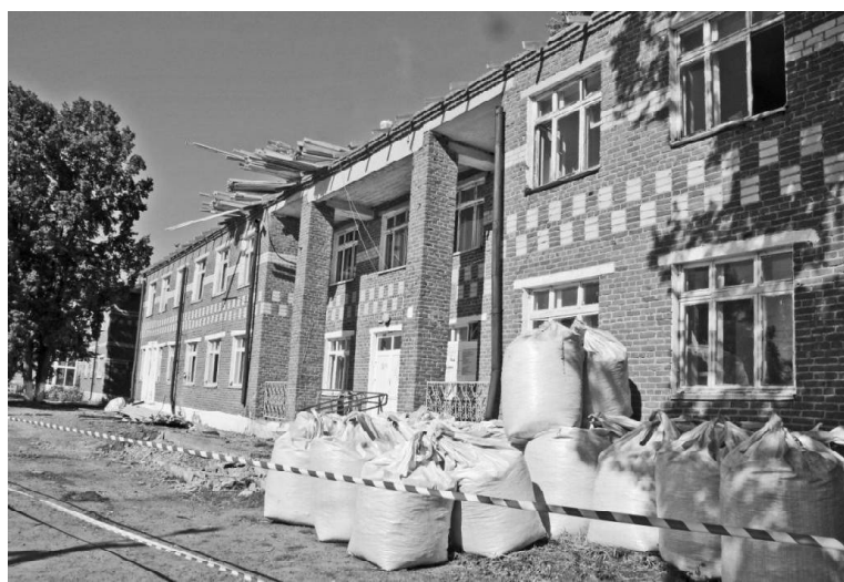
▶ Ремонт поликлиники // Фото Марины ИЛЬЧЕНКО
