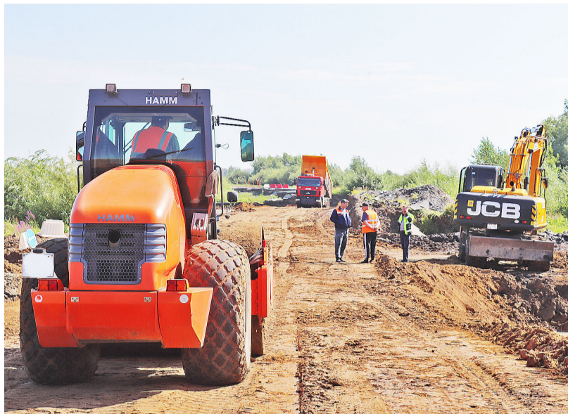
Восстановление дорог после паводка 2024 года в Казанском районе
