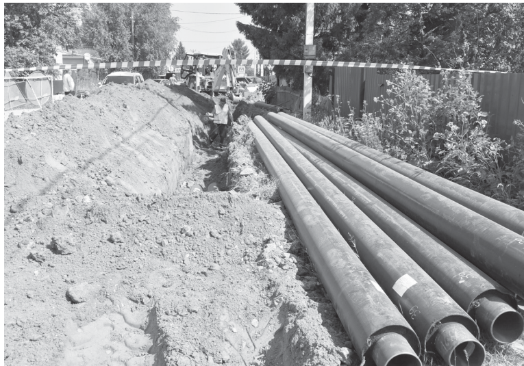
Всего в Ярково этим летом будет заменено более двух километров теплосетей
