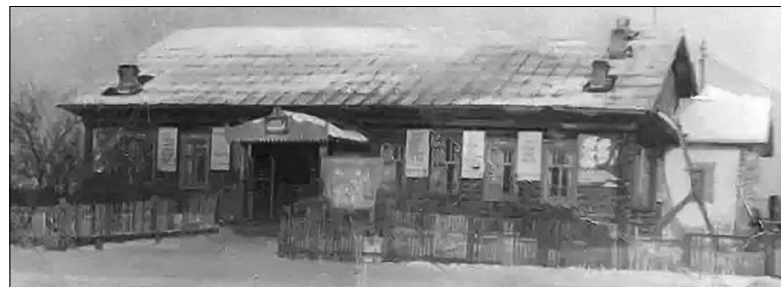
Деревянное здание клуба в селе Усть-Ламенке существовало с 1938 года до 90-х
