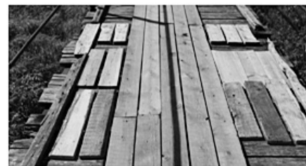
Вид переходов после временного ремонта
