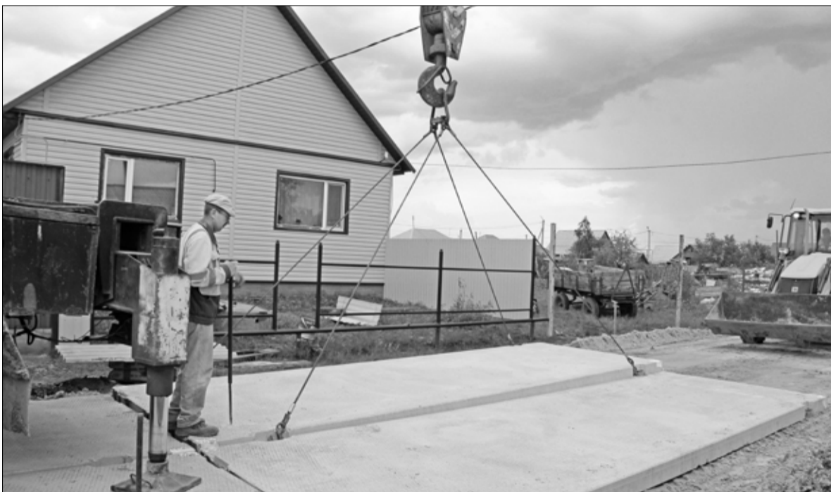
Жители переулка Пионерского рады новой дороге из железобетонных плит
