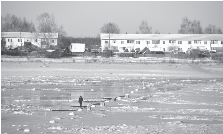
Идёт заливка транспортной полосы
