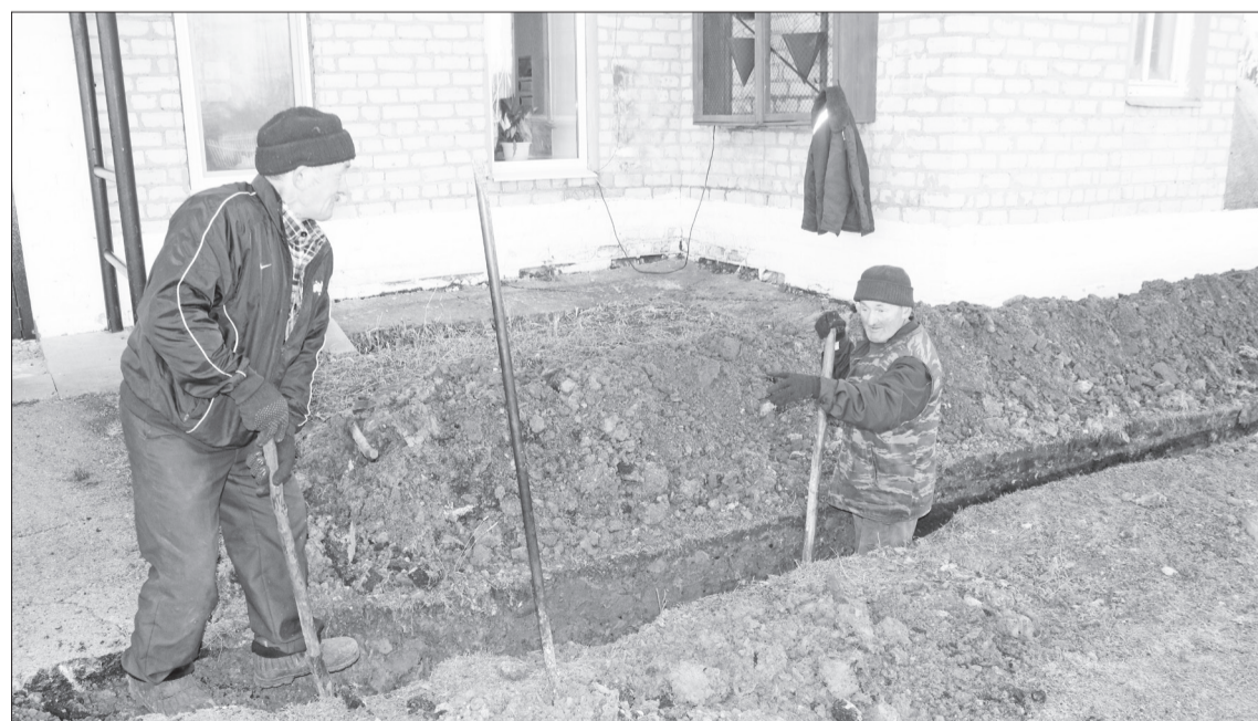
📷 Александр Иванов и Александр Пуркин готовят траншею для прокладки газовой трубы к администрации сельского поселения. / ФОТО АВТОРА.
