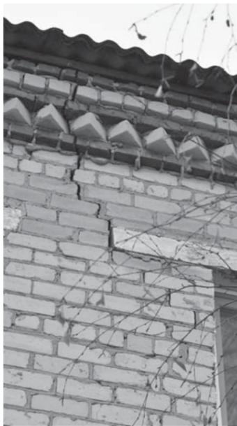
Эта трещина протянулась от крыши до фундамента
