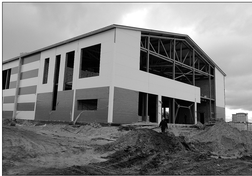
В Мальково строится спорткомплекс.
