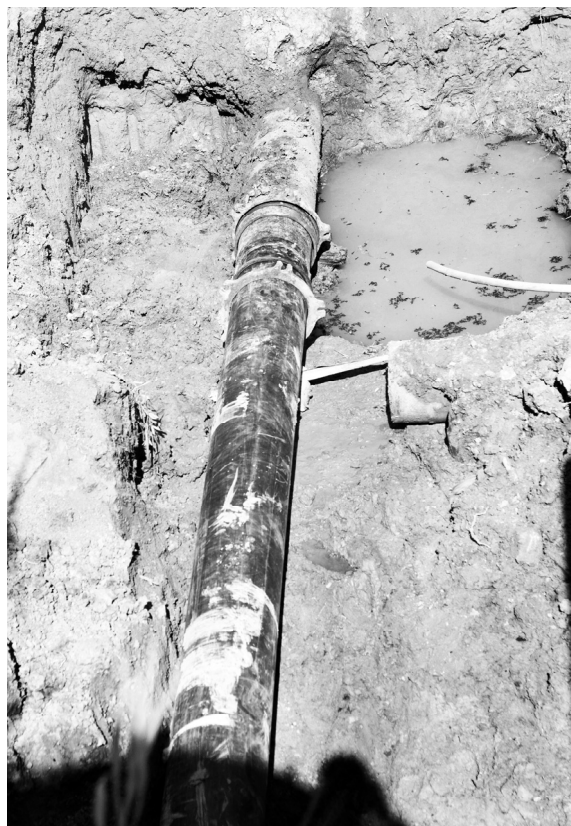
Новая труба будет служить долго
