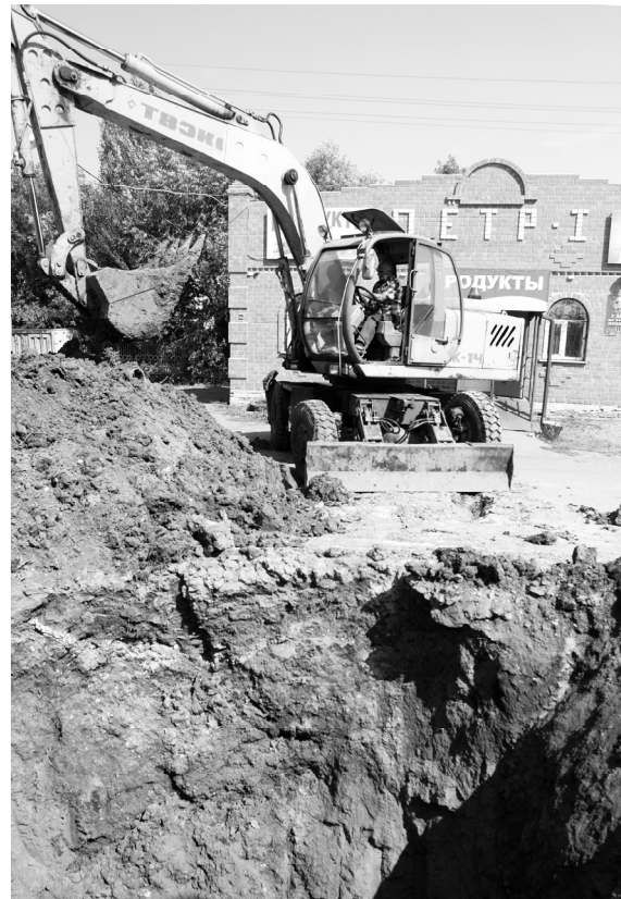
Идет работа на объекте
