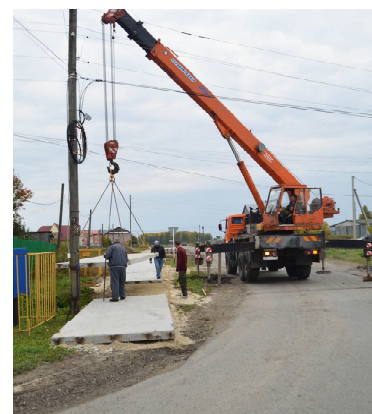
Вдоль улицы Российской укладка шестиметровых дорожных плит для тротуара производится автокраном
