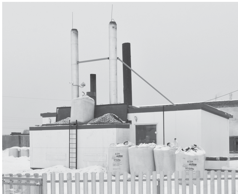
В 2022 году в Новоалександровке запущена в работу новая котельная
