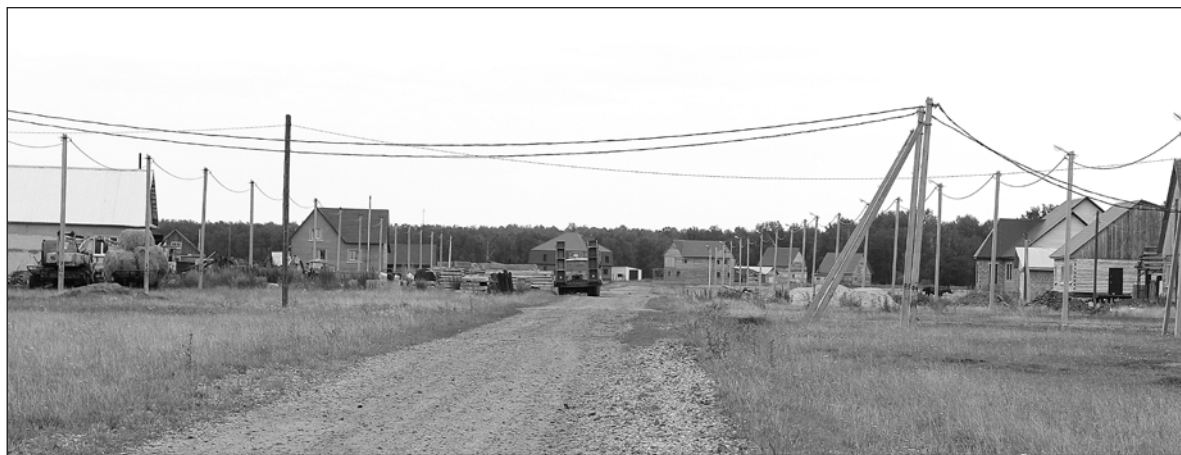
Строительная площадка в залинейной части посёлка Голышманово
