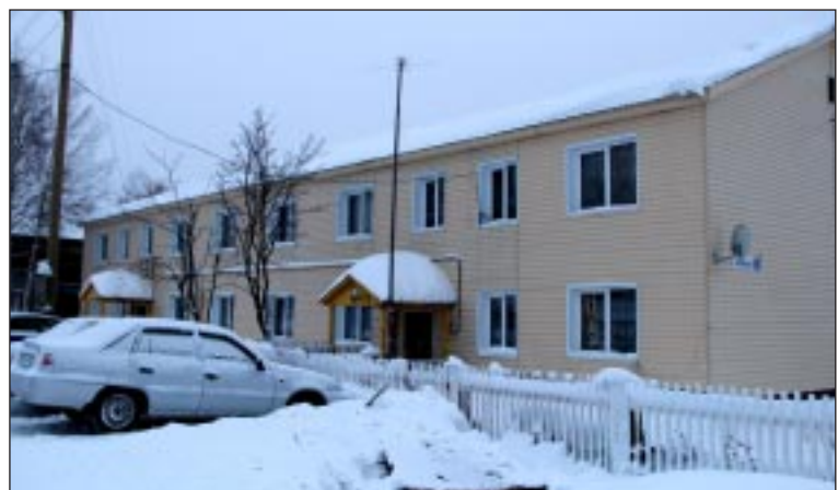
Дом № 1 по ул. Октябрьская после капитального ремонта.
