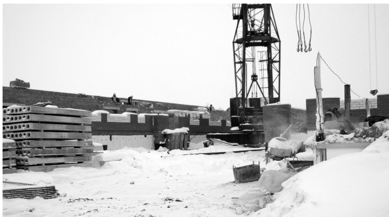
Идет строительство школы в с.Вагай
