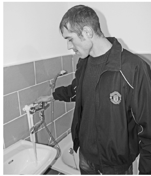
* ...А Николай Владимирович проверяет водопроводную систему
