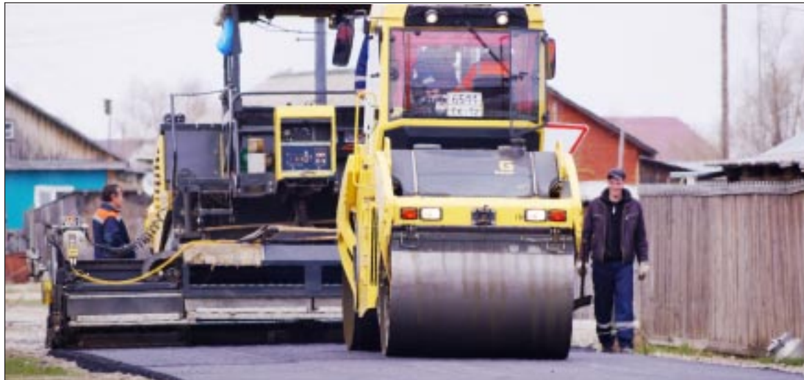
Укладывается финишный слой асфальта на улице в Первомайской в с. Уват.
