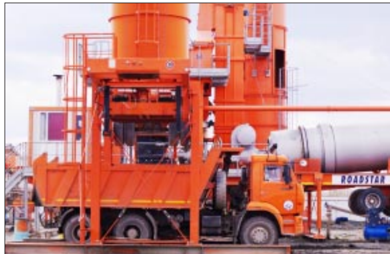
Идёт загрузка асфальтобетона.
