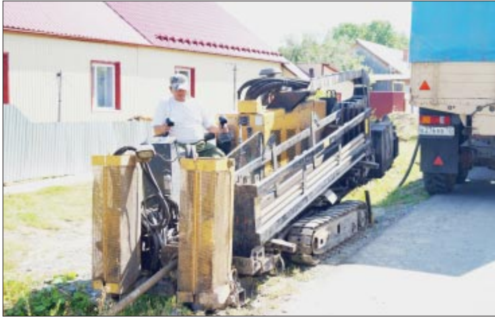
Производится монтаж магистрального газопровода в пос. Нагорный.
