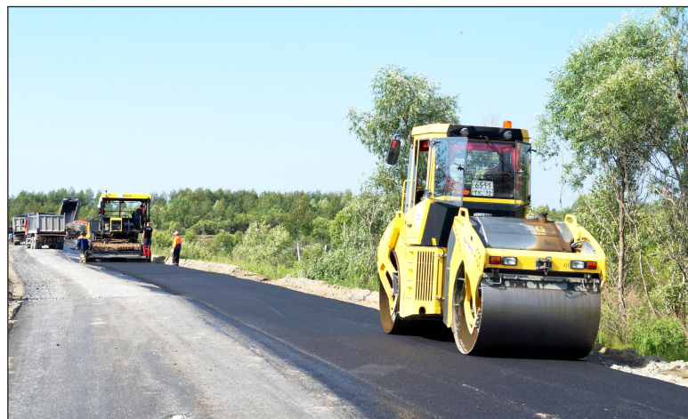
Уватское ДСРУ ведёт ремонт дорог.
