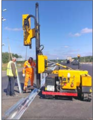
Установка барьерного ограждения на развилке автодороги Р404 в районе ПВК
