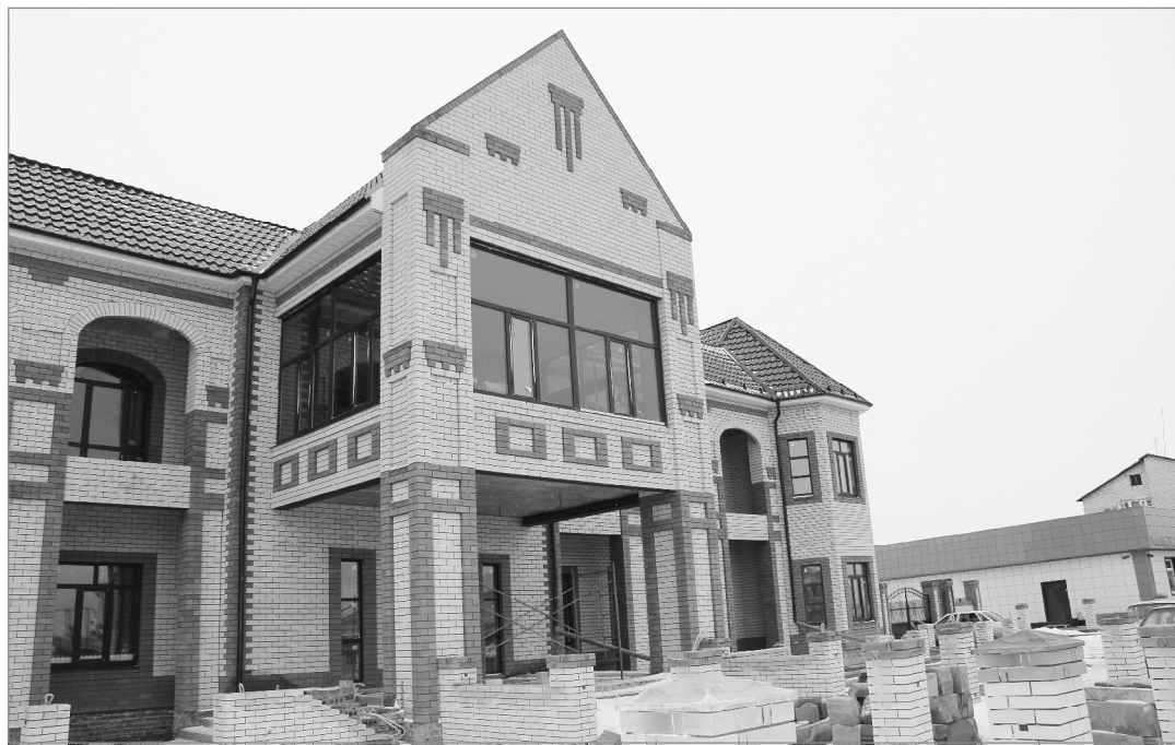
Строительство на стадии завершения
