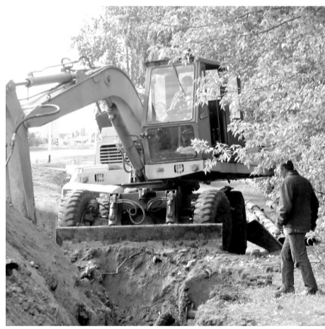
• К 10 сентября должны закончить ремонт теплотрассы на городской улице Энергетиков.
