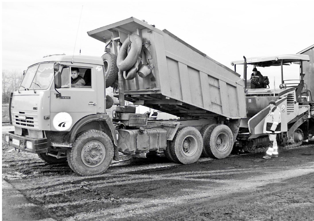
Вот и новая порция тёплого асфальта подспела. Через пару-тройку часов он покроет полосу дороги.
