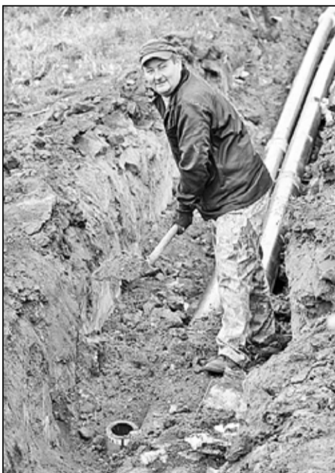
Работник МУПЖКХ Виталий Моисевич Петров проводит изоляцию стыков трубопровода
