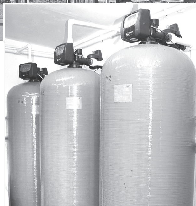
Очистные сооружения на центральных сетях водоснабжения села Хохлово заработают уже в июле, и из домашних кранов потечёт чистая питьевая вода
