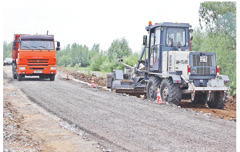
Процесс восстановления автомобильной дороги
