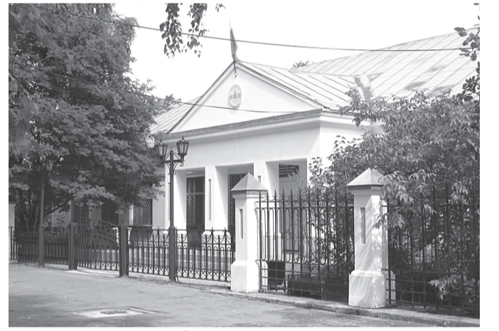
Главный корпус Тобольской комплексной научной станции
